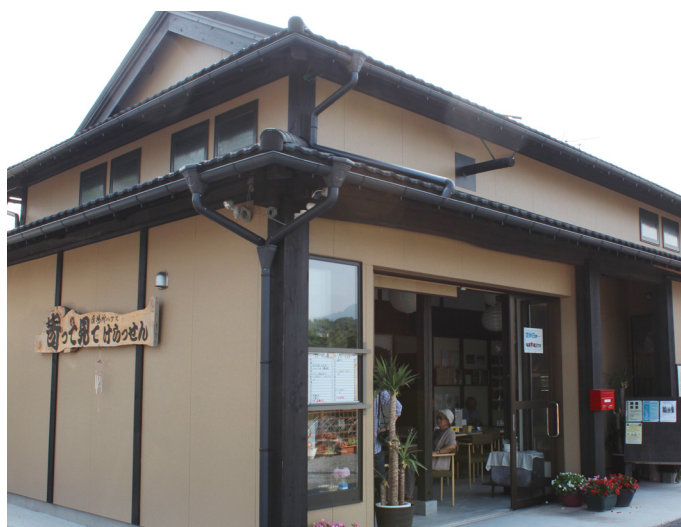
陸前高田市内の古民家を移設利用した「居場所ハウス」
