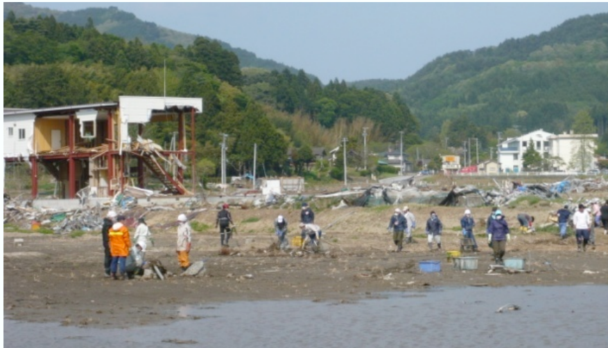
ボランティアによる瓦礫撤去作業（陸前高田市）
