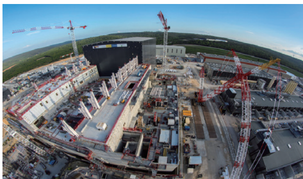
ITER（国際熱核融合実験炉）の建設状況（2019年10月） （仏サン＝ポール＝レ＝デュランス市カダラッシュ） ©ITER Organization
