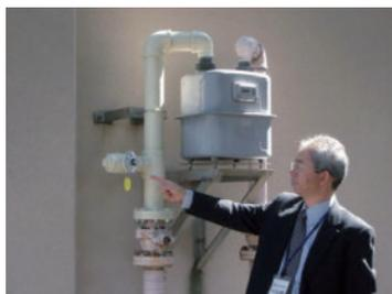
⑤LPガスから都市ガスへの変換器の接続口
