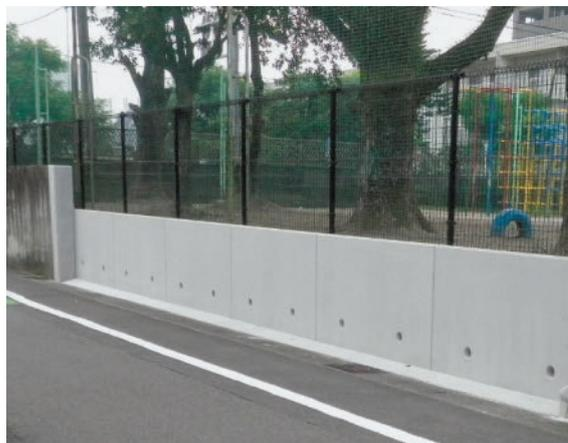
安全対策の例：ブロック塀を撤去し、フェンスに再整備した事例
