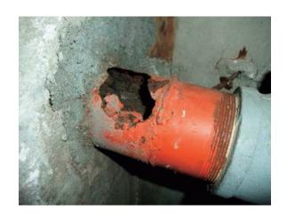
劣化による配管破損
