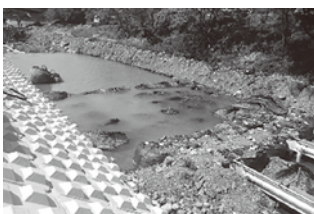
カキ殻を利用した掘削時の汚濁処理
