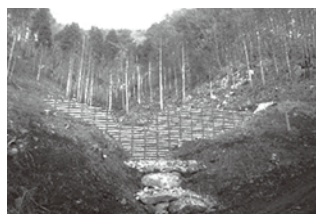
建設工事(治山) 間伐材を利用した谷止工(中身は石)
