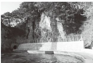
浄土ヶ浜遊歩道の復旧工事 国立公園内のため、景観を損ねないように落石対策を行う
