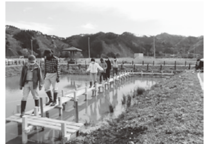
完成した木道を渡ってみました 夏にはミズアオイを見ることができます
